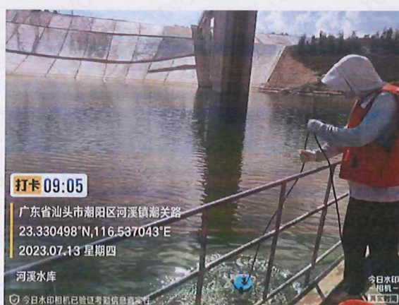
河溪水库取水口
