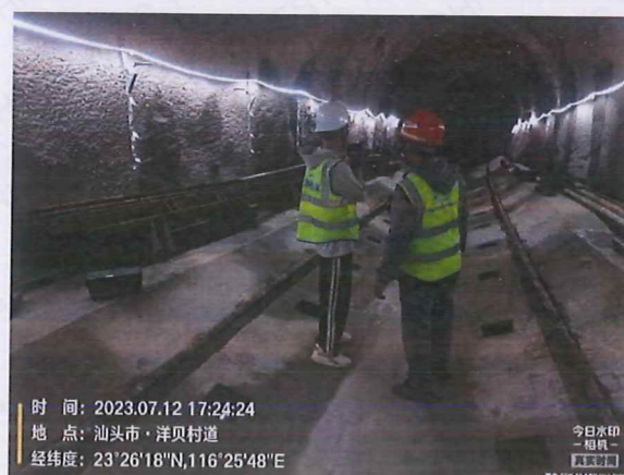
TBM 隧道洞口开端 100 米处
